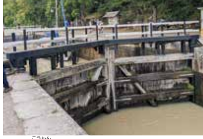
運河の閘門(水面に高低差のある場所で、水面を昇降させて船を行き来させるための装置)
