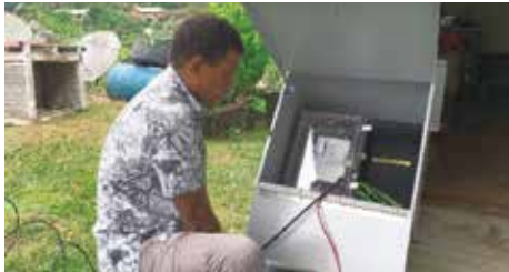
雨量計の動作確認
